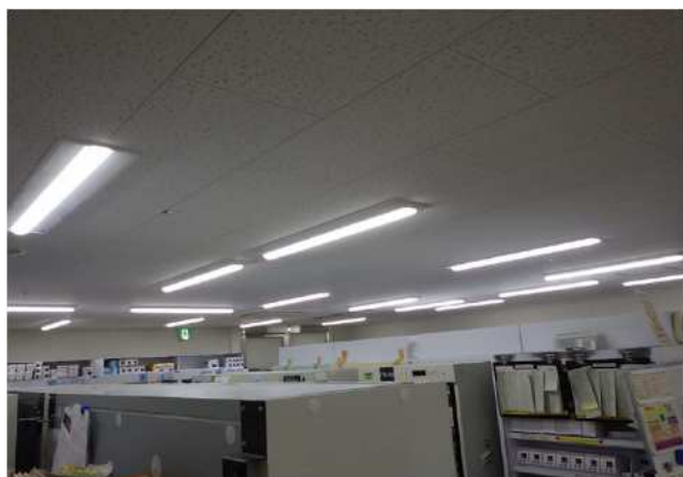
【照明器具 LED 更新 病院外来棟B 1階】
